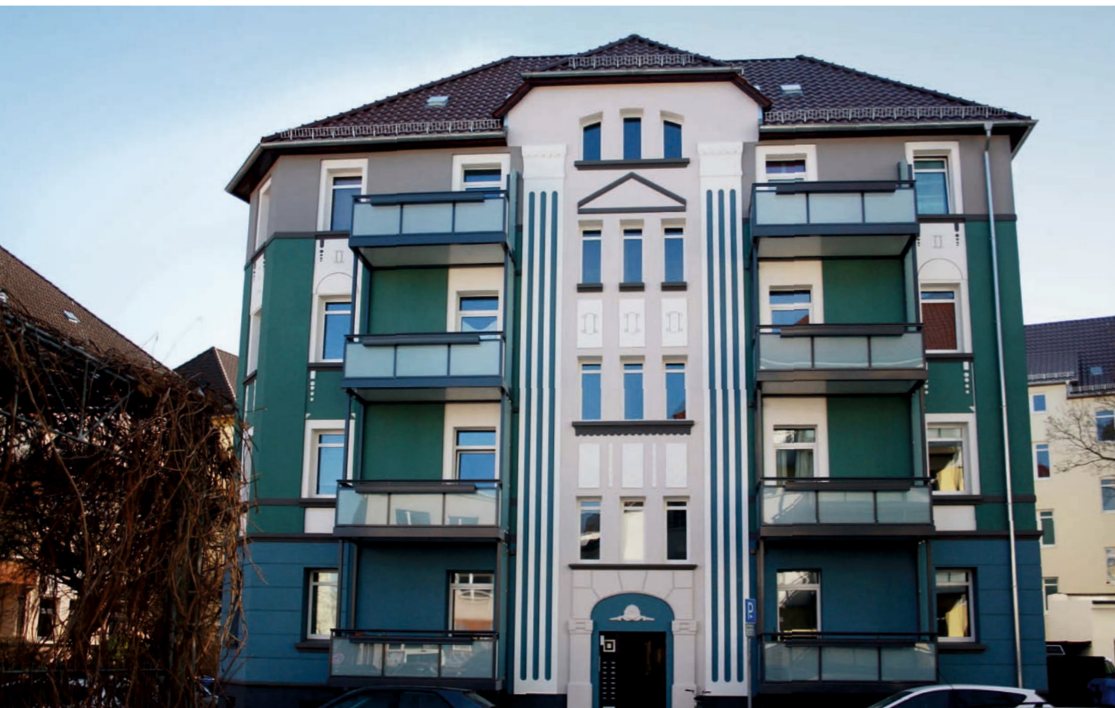
Blick auf die Broitzemer Straße 8
